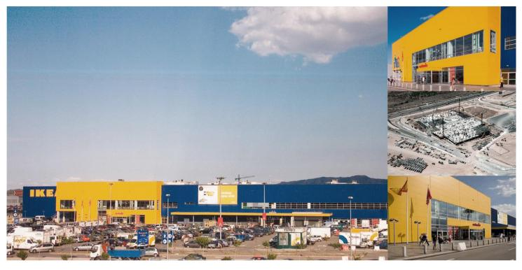
El edificio de la nueva tienda IKEA en Murcia tiene una forma aproximadamente rectangular, con unas dimensiones interiores máximas de 160.0 m en una dirección y 120 m en la otra. El edificio consiste en un sótano y dos niveles sobre rasante, planta baja y planta primera.
